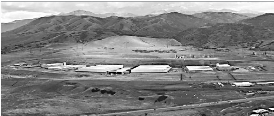
Рис. 1.2. Дата-центр в штате Юта (источник: https://en.wikipedia.org/wiki/Utah_Data_Center )
